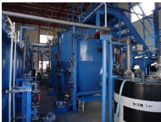
(a) 硝酸性窒素処理設備
