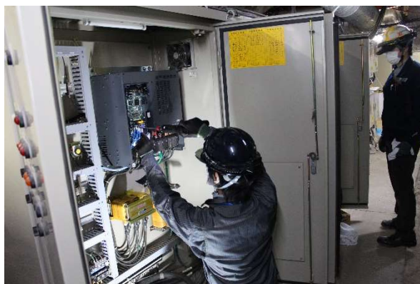
(b) 排水設備の更新
