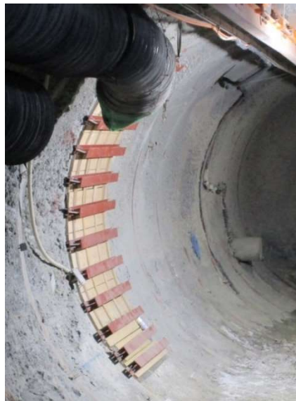
図 43 吹付け試験施工後の養生
