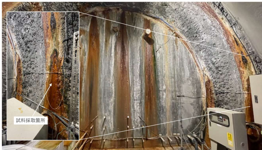
図 101 試験坑道 4 壁面からの浸出水の採取箇所
