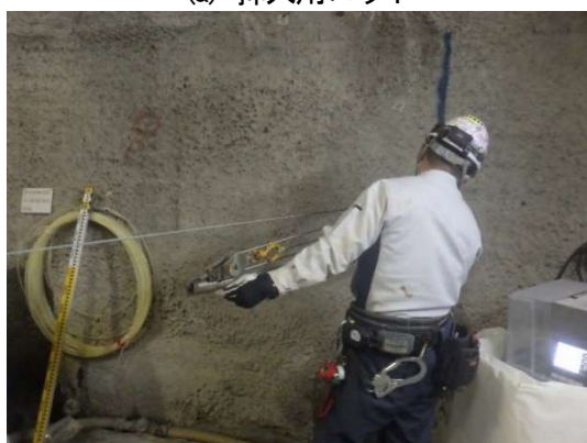
(c) 定置用コンテナの挿入作業
