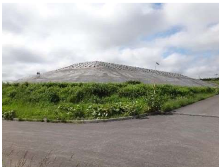
図 122 掘削土（ズリ）置場
